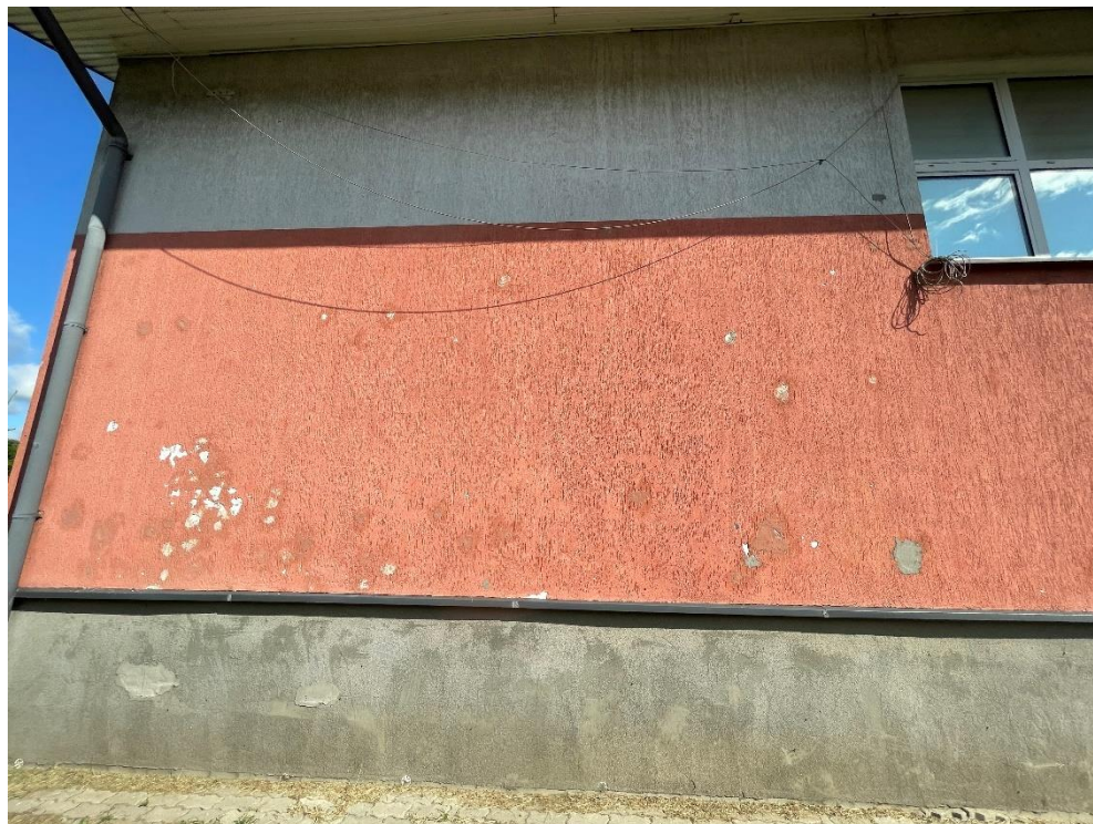
Fot. Nr 23 – Elewacja z widocznymi plamami od zawilgocenia i ubytkami
