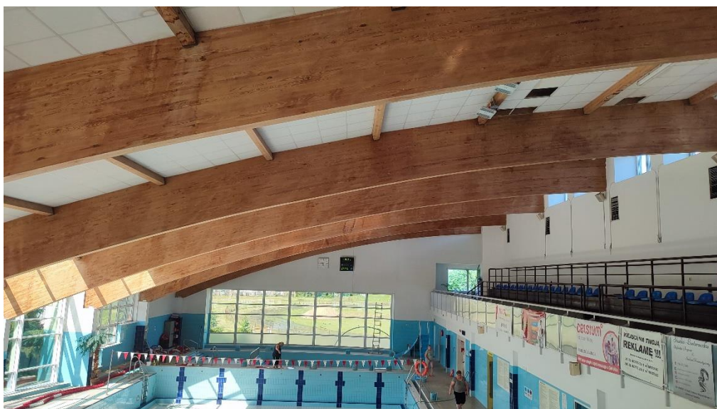
Fot. Nr 9 – Widok dźwigarów głównych z widocznymi przebarwieniami
