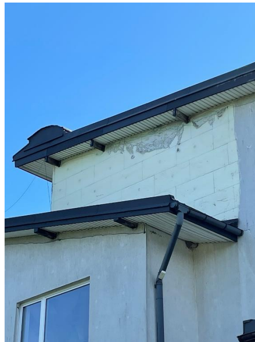
Fot. Nr 21 i 22 – Widok miejsc w których styropian odpadł od konstrukcji ściany
