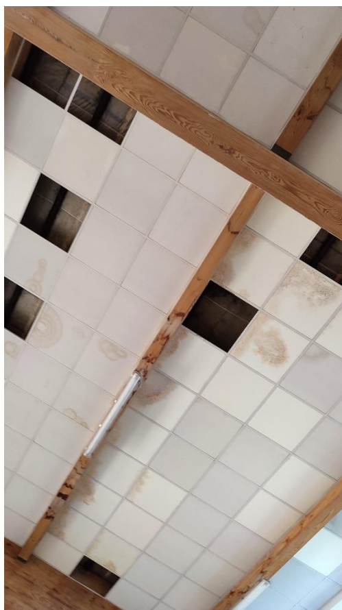
Fot. Nr 10 i 11 – Widok sufitu podwieszanego z widocznymi śladami po zamoczeniu
