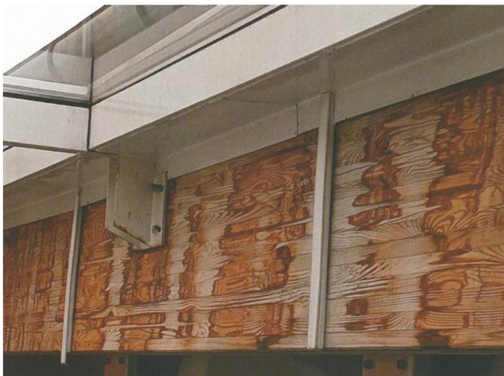
Fot. Nr 12 – Widok płatwi z drewna klejonego przy szklanej fasadzie
