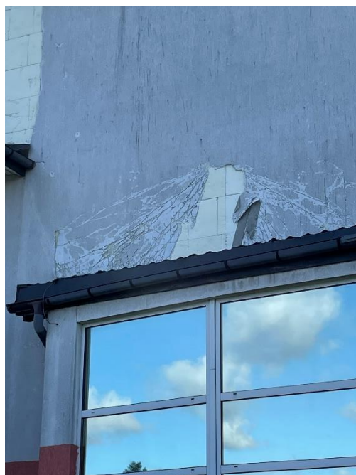
Fot. Nr 21 i 22 – Widok miejsc w których styropian odpadł od konstrukcji ściany
