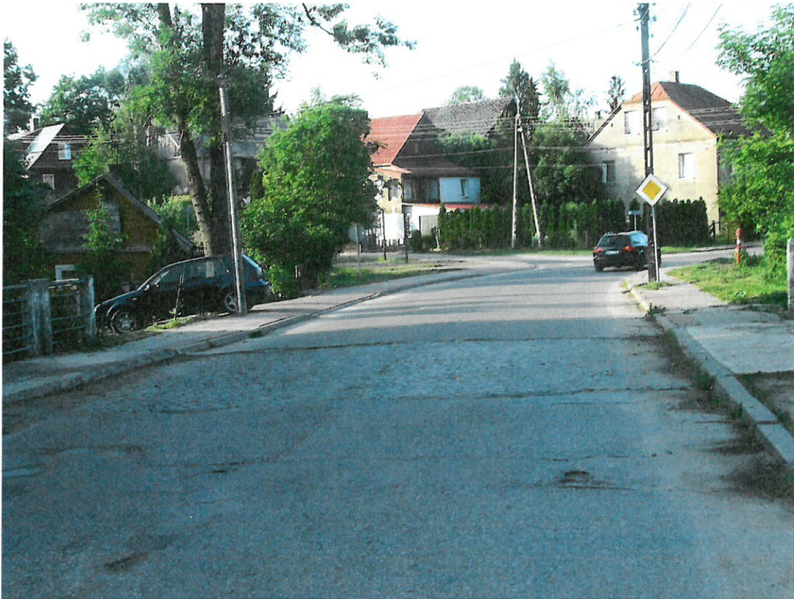
Fot. 1. Widok mostu od strony najazdu
