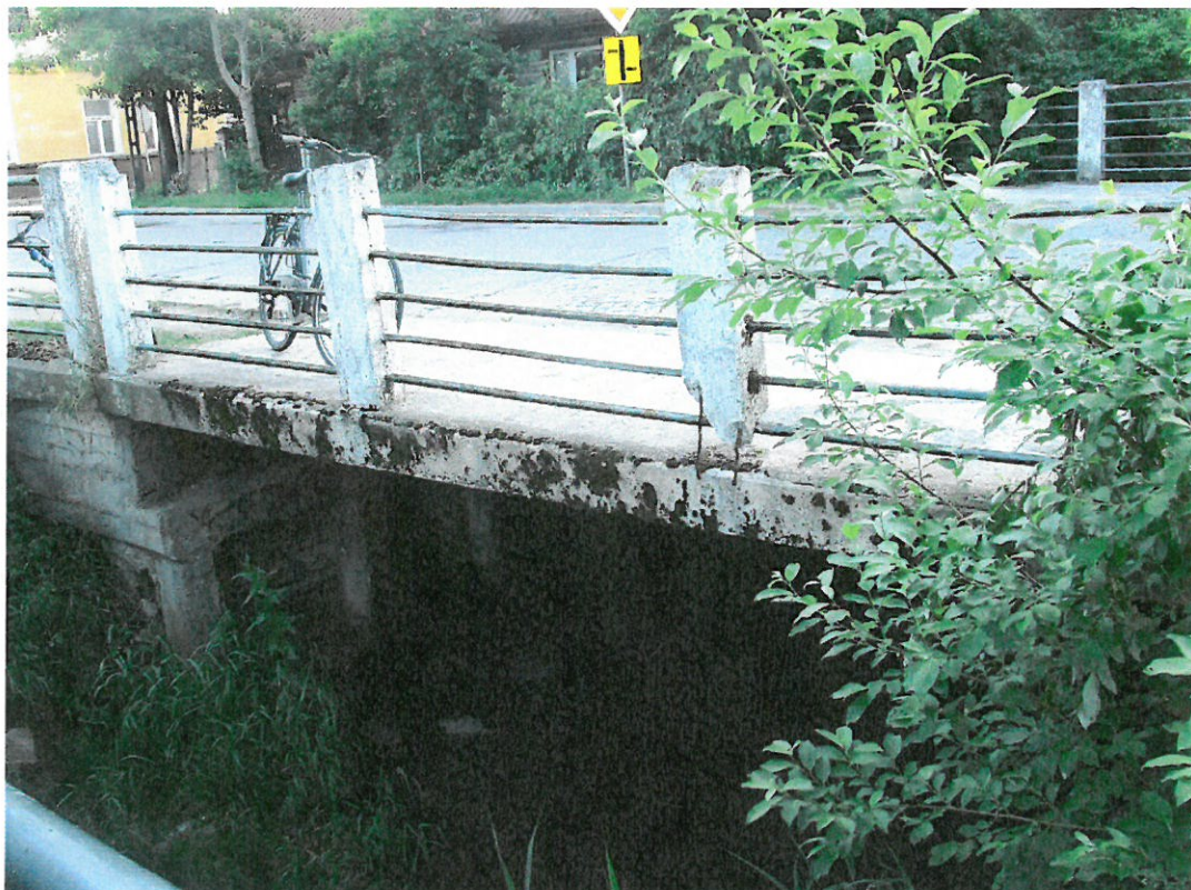
Fot. 2. Widok mostu z boku
