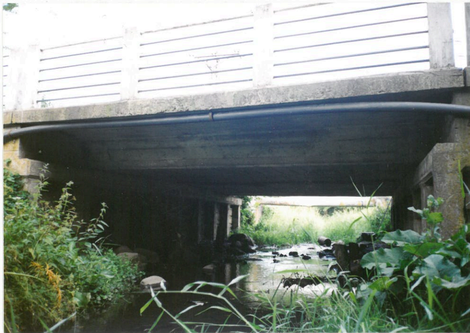
Rys. 1. Widok ogólny wiaduktu od strony zachodniej
