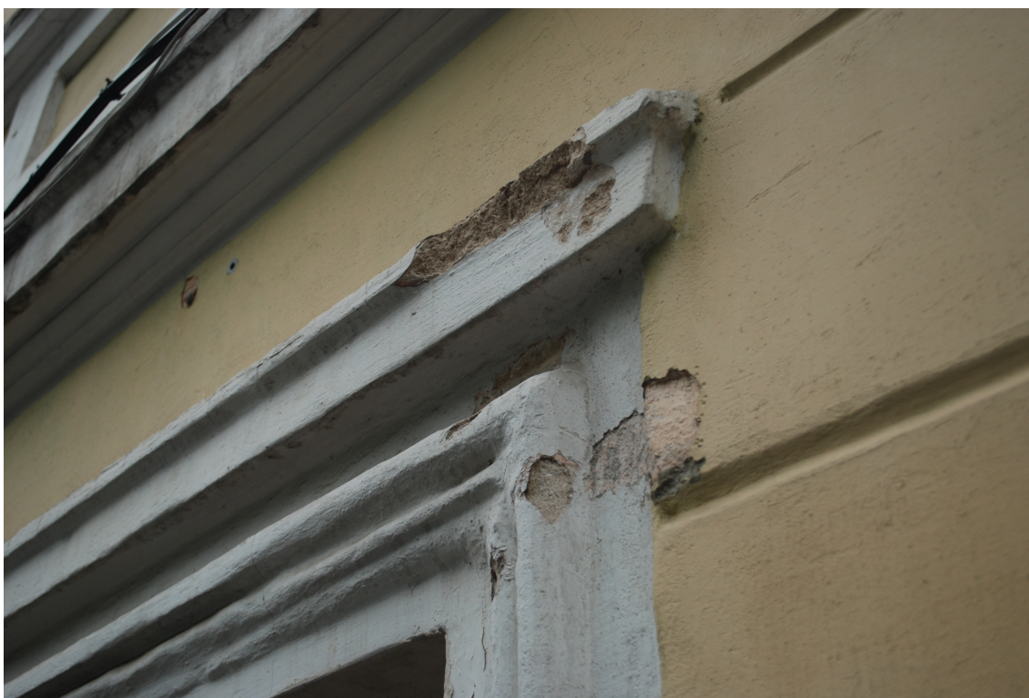
Fot.8. Widok uszkodzeń nadproża.
