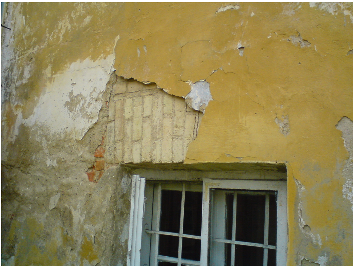
Fot.6. Widok nadproża okiennego. Widoczne rysy.
