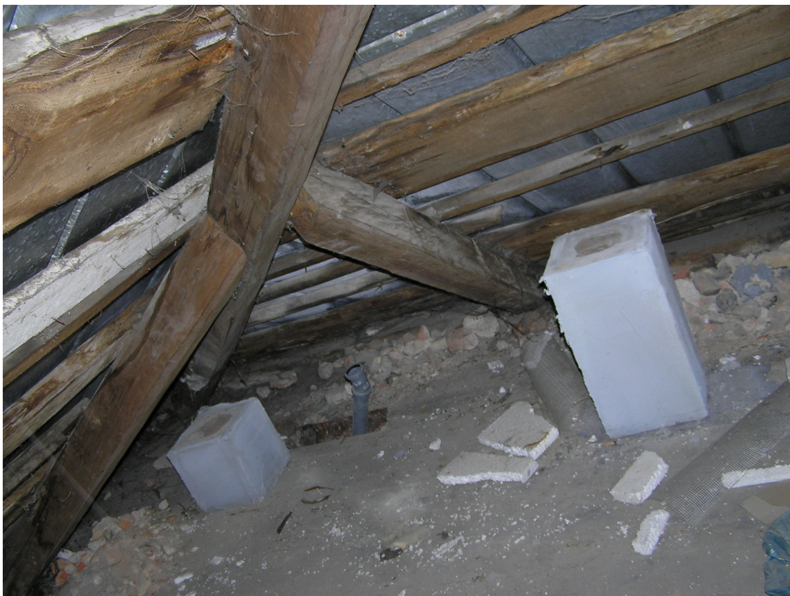
Fot.15. Więźba dachowa. Krokień narożna. Widoczna degradacja ołączenia spowodowana wodą opadową z dachu.
