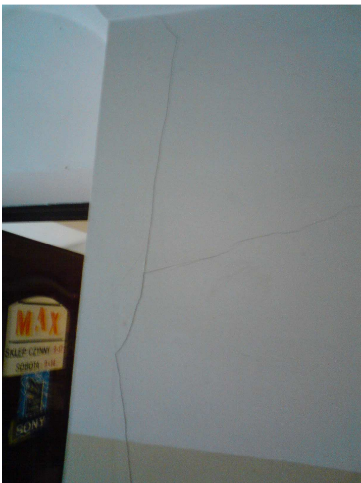
Fot.12. Widok ściany. Rysy pionowe i poziome.
