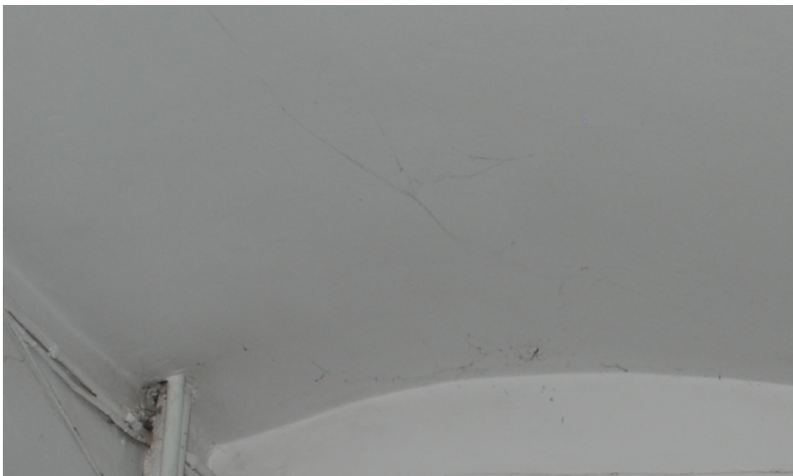
Fot.10. Widok stropu. Widoczne rysy sklepienia ceglanego.
