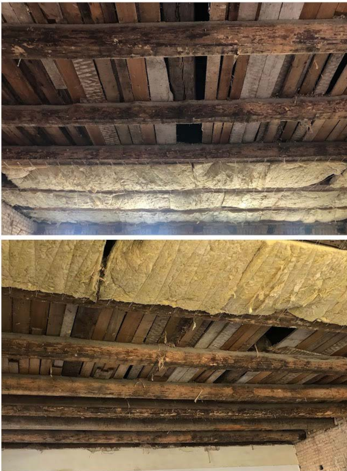
Fot. 46-47. Belki stropu – uszkodzenia spowodowane żerowaniem larw spuszczela pospolitego ( Hylotrupes bajulus ) – widoczne liczne otwory wylotowe – obecność mączki świadczy o obecności aktywnych żerowisk, rozwój zagrzybienia grzybami domowymi i pleśniewymi, początki brunatnego rozkładu drewna.
