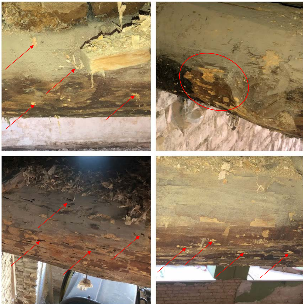
Fot. 50-53. Belki stropu – uszkodzenia spowodowane żerowaniem larw spuszczela pospolitego ( Hylotrupes bajulus ) – liczne otwory wylotowe, obecność mączki drzewnej świadczy o aktywnych żerowiskach.
