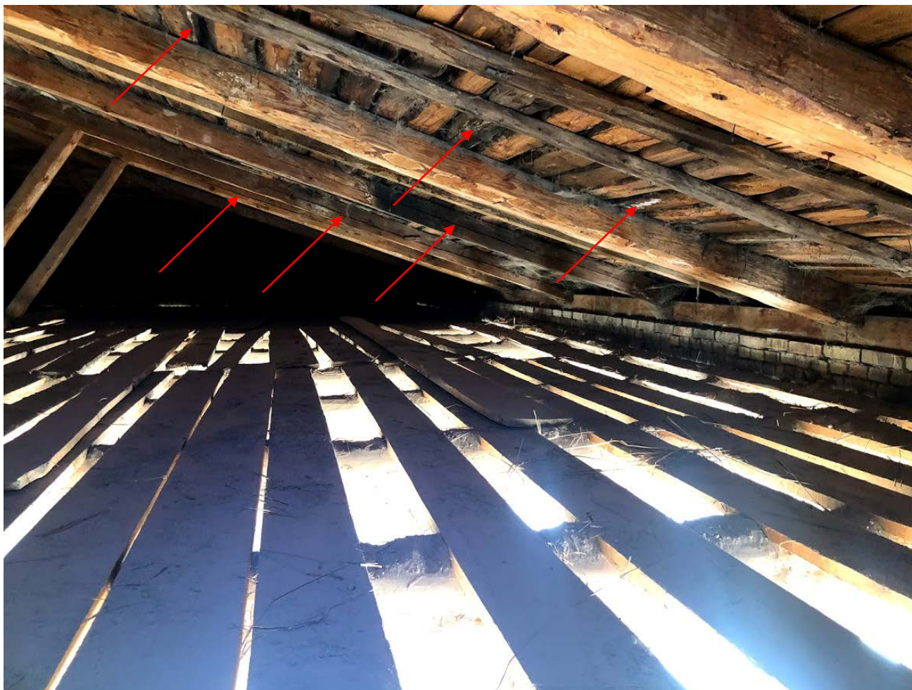
Fot. 10. Więźba dachowa – spękania krokwi, widoczne ślady zacieków i wysoleń po zaciekach wód opadowych na deskach poszycia i krokwiach,
