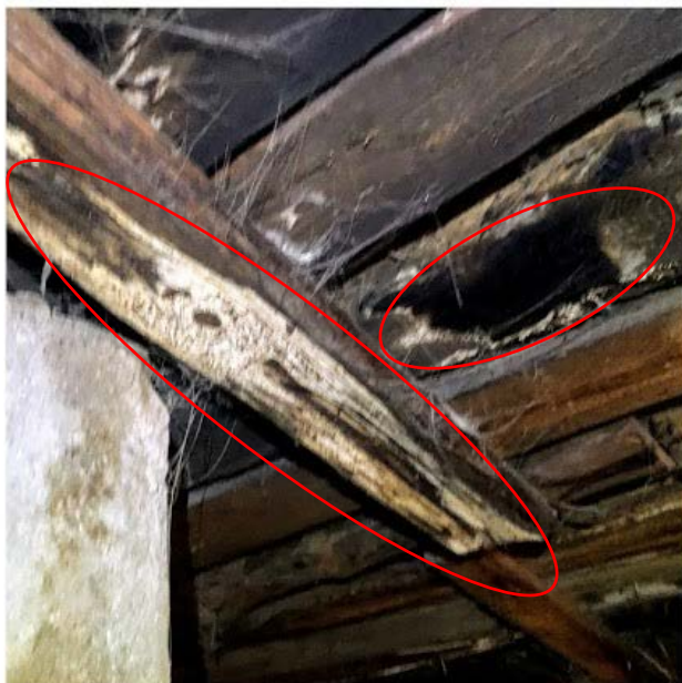
Fot. 19-22. Więźba dachowa – widok porażenia biologicznego desek połaciowych grzybem domowym ( Serpula lacrymans ) różne stadia rozwoju. Rozwój porażenia biologicznego w wyniku zawilgocenia – zagrzybienie powierzchni desek, rozkład strukturalny, utrata właściwości mechanicznych.
