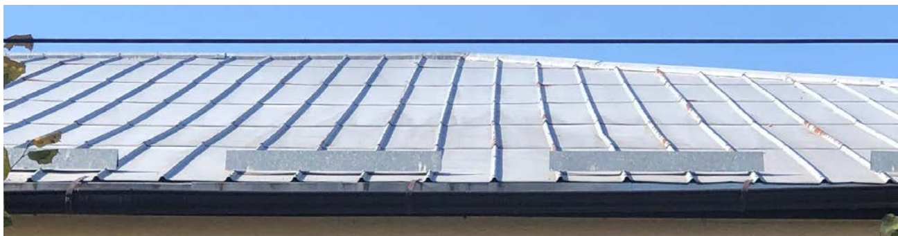
Fot. 2. Pokrycie dachu – blacha stalowa ocynkowana z początkami korozji w miejscach utraty ochronnej powłoki ocynku. Widoczne ugięcia poszycia – brak jednorodnego spadku – spowodowane ugięciem krokwi.
