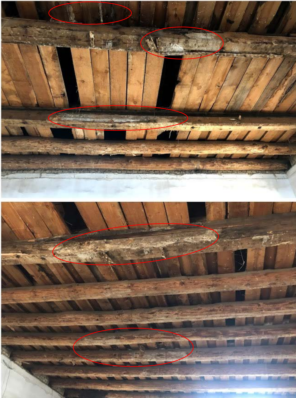
Fot. 48-49. Belki stropu – rozwój zagrzybienia grzybami domowymi i pleśniewymi.
