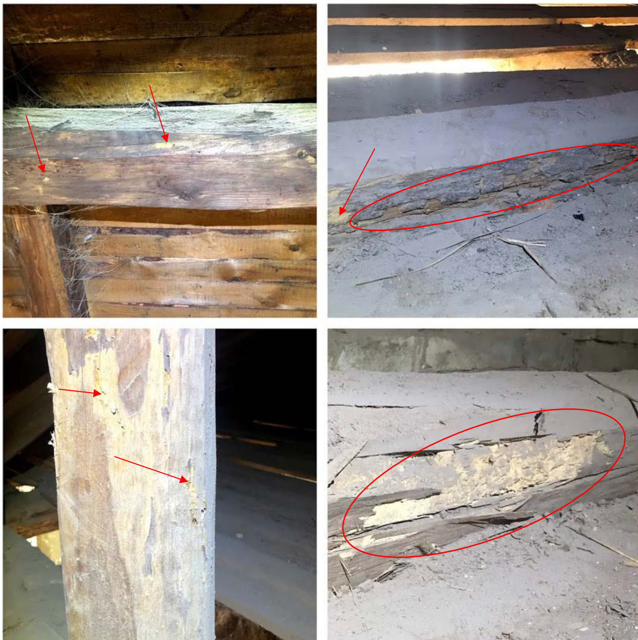
Fot. 31-34. Więźba dachowa – uszkodzenia belek i słupa spowodowane działaniami owadów – technicznych szkodników drewna - spuszczela pospolitego ( Hylotrupes bajulus ) – widoczne otwory wylotowe, obecność mączki drzewnej – żerowisko aktywne.
