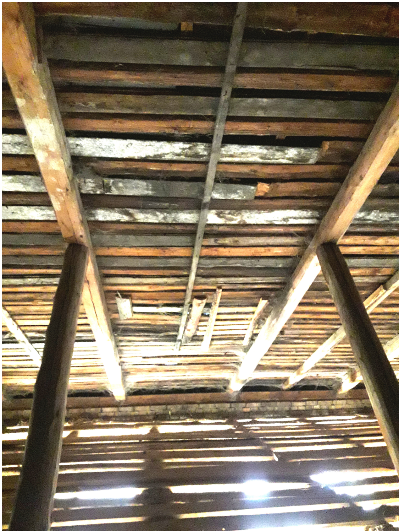
Fot. 4. Widok na krokwie oraz poszycie z desek
