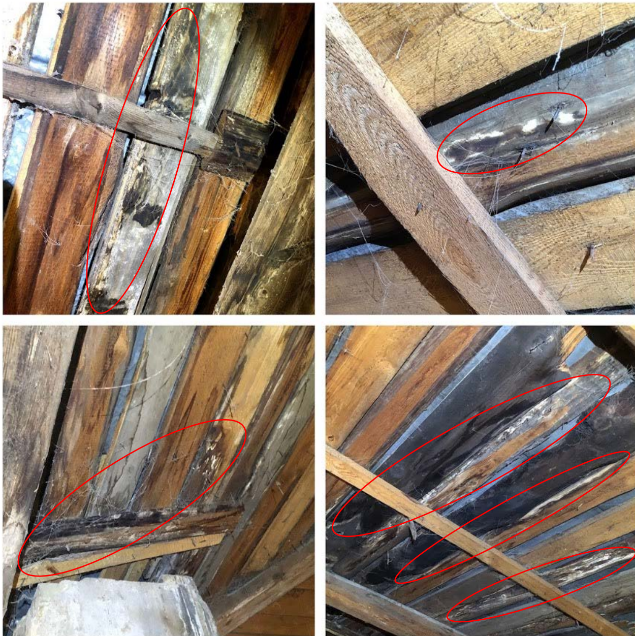
Fot. 15-18. Więźba dachowa – uszkodzenia desek połaciowych spowodowane zawilgoceniem i rozwojem porażenia biologicznego grzybem domowym ( Serpula lacrymans ) - różne stadia rozwoju.
