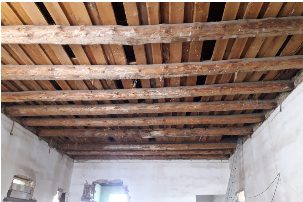
Fot. 3. Widok na belki stropowe (widoczne ugięcie niektórych belek stropowych)
