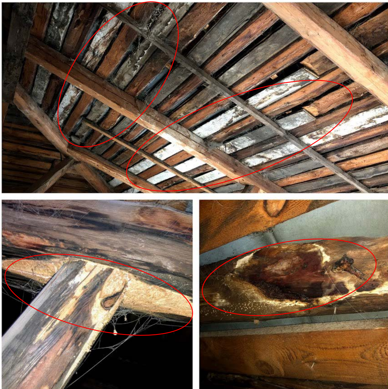
Fot. 23-26. Więźba dachowa – – widok porażenia biologicznego desek połaciowych grzybem domowym ( Serpula lacrymans ) różne stadia rozwoju. Rozwój porażenia biologicznego – zagrzybienie powierzchni desek, rozkład strukturalny, utrata właściwości mechanicznych.
