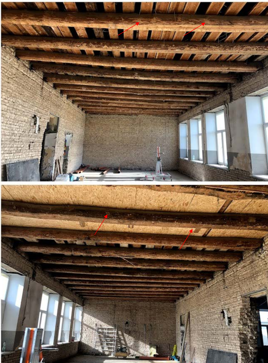
Fot. 40-41. Belki stropowe – widok po demontażu sufitów podwieszanych widoczne liczne otwory wylotowe owadów – technicznych szkodników drewna – obecność mączki świadczy o obecności aktywnych żerowisk.
