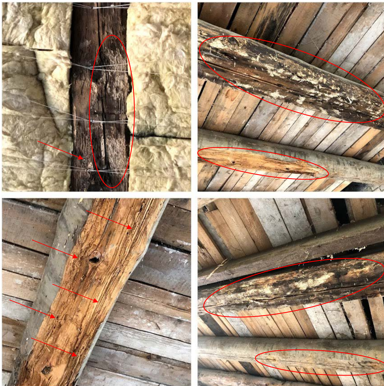
Fot. 62-65. Belki stropu – uszkodzenia spowodowane żerowaniem larw spuszczela pospolitego ( Hylotrupes bajulus ) – widoczne liczne otwory wylotowe – rozwój zagrzybienia grzybami domowymi i pleśniowymi, początki brunatnego rozkładu drewna.
