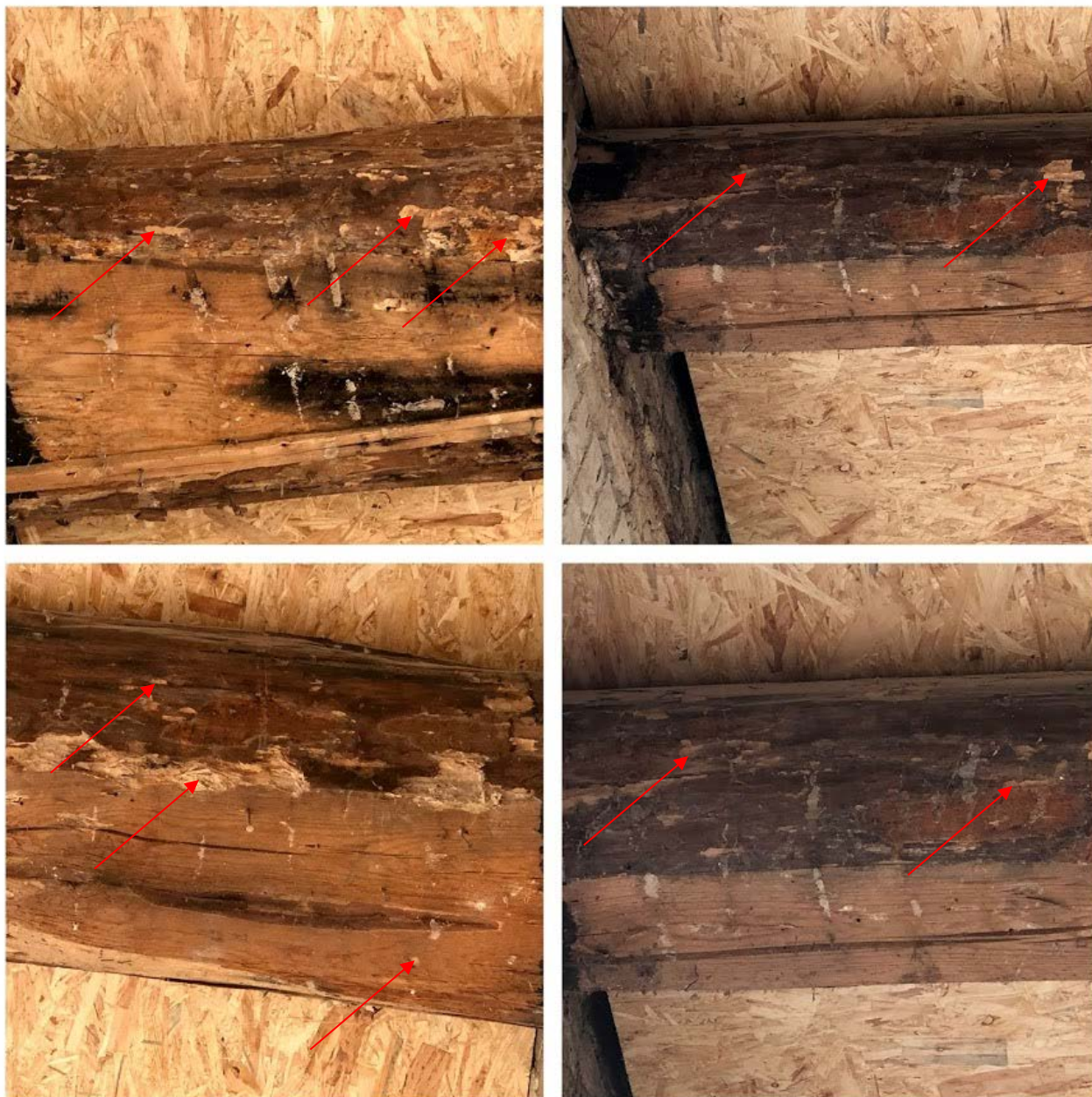
Fot. 54-57. Belki stropu – uszkodzenia spowodowane żerowaniem larw spuszczela pospolitego ( Hylotrupes bajulus ).
