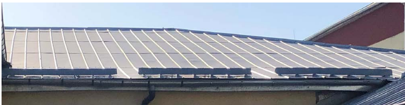
Fot. 1. Pokrycie dachu – widoczne ugięcia poszycia – brak jednorodnego spadku – spowodowane ugięciem krokwi.
