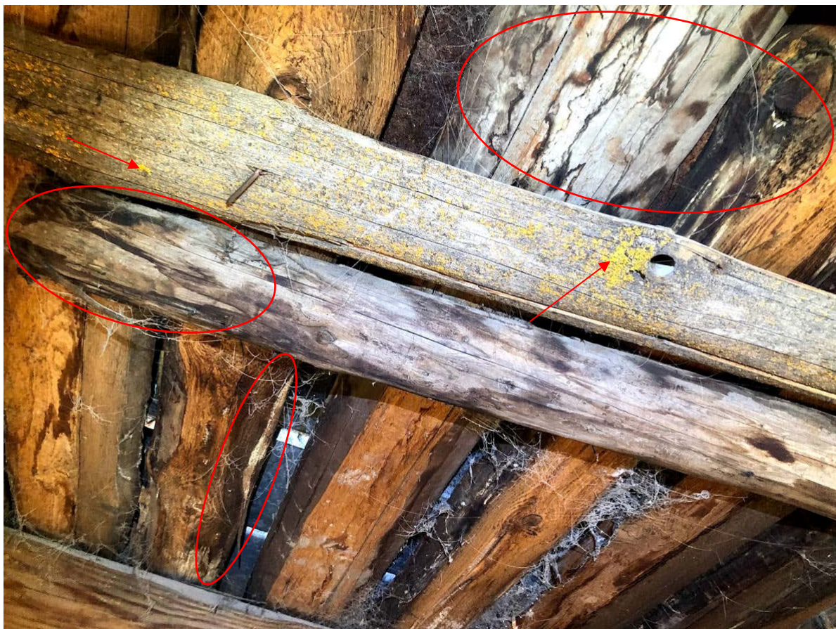
Fot. 39. Więźba dachowa – rozwój porostów na belce, zagrzybienie desek połaciowych grzybami pleśniowymi i domowymi, liczne ślady zawilgocenia i zasolenia desek.
