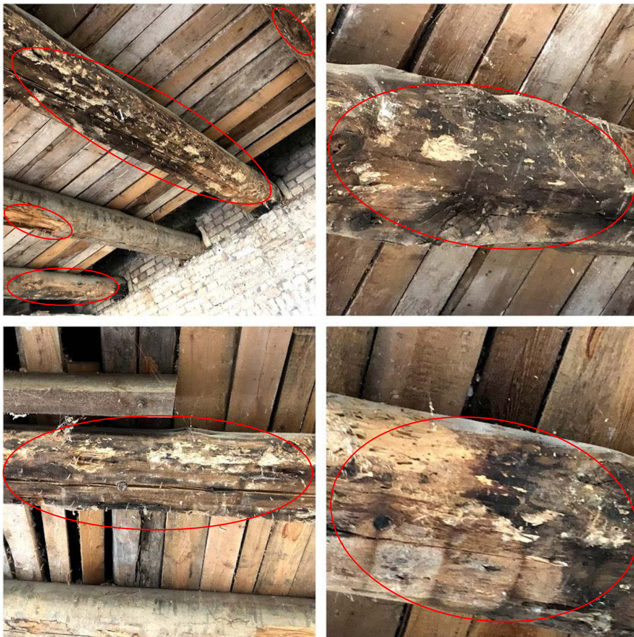
Fot. 58-61. Belki stropu – uszkodzenia spowodowane żerowaniem larw spuszczela pospolitego ( Hylotrupes bajulus ) i zagrzybieniem, początki brunatnego rozkładu drewna.
