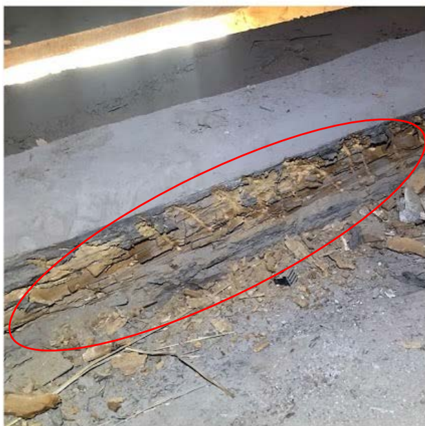
Fot. 35-38. Więźba dachowa – uszkodzenia belek i słupa spowodowane działaniami owadów – technicznych szkodników drewna - spuszczela pospolitego ( Hylotrupes bajulus ) – widoczne otwory wylotowe, obecność mączki drzewnej – żerowisko aktywne, brunatny rozkład drewna budowlanego.
