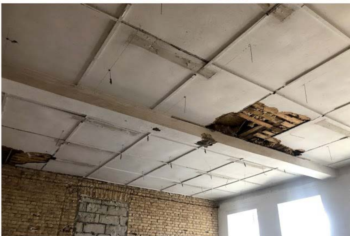
Fot. 44-45. Strop poddasza – widok belek stropowych po demontażu sufitu i w trakcie demontażu – pomieszczenia od strony ul Mickiewicza.
