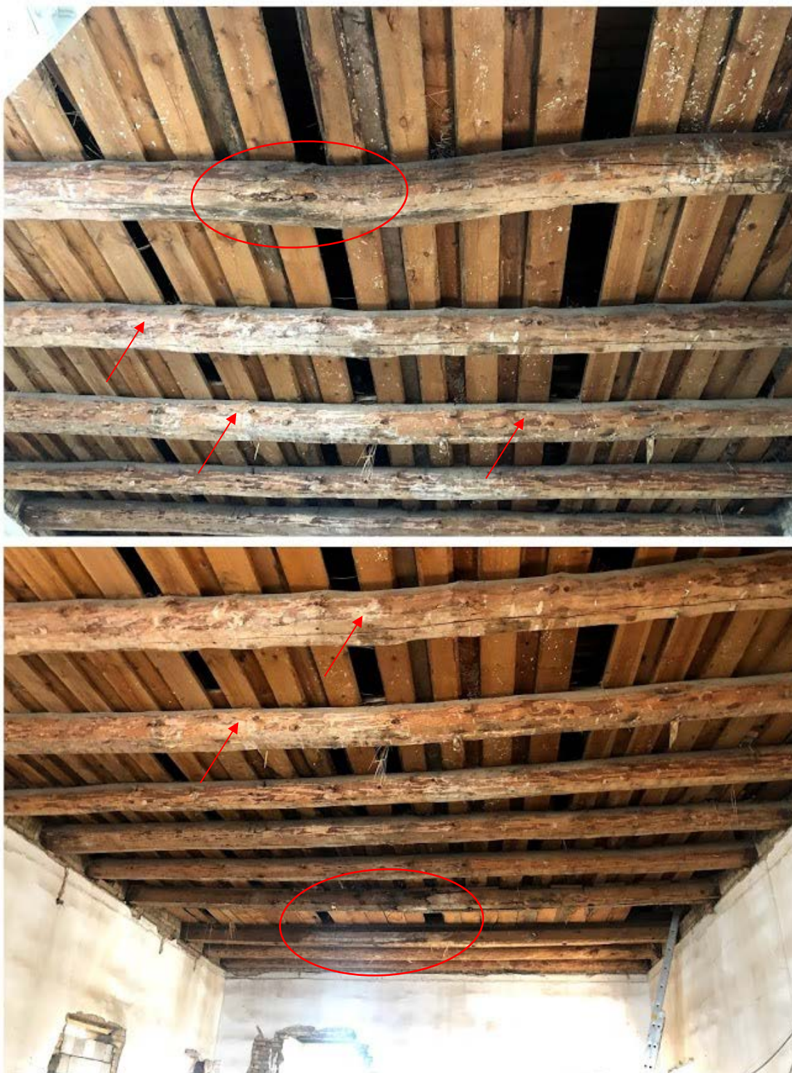
Fot. 42-43 Belki stropu – uszkodzenia spowodowane żerowaniem larw spuszczela pospolitego ( Hylotrupes bajulus ) – widok po demontażu sufitów podwieszanych, widoczne liczne otwory wylotowe – obecność mączki świadczy o obecności aktywnych żerowisk, rozwój zagrzybienia grzybami domowymi i pleśniowymi.
