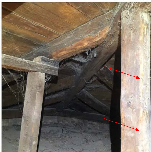
Fot. 35-38. Więźba dachowa – uszkodzenia belek i słupa spowodowane działaniami owadów – technicznych szkodników drewna - spuszczela pospolitego ( Hylotrupes bajulus ) – widoczne otwory wylotowe, obecność mączki drzewnej – żerowisko aktywne, brunatny rozkład drewna budowlanego.
