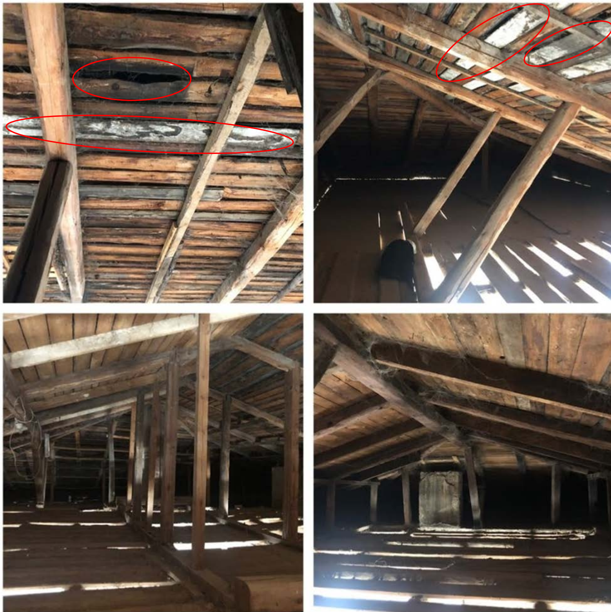
Fot. 11-14. Więźba dachowa – widok ogólny elementów konstrukcji więźby dachowej. Widoczne ślady wysoleni po zaciekach wód opadowych, oznaki zagrzybienia: naloty w kolorze czarnym, szarym i brązowym.
