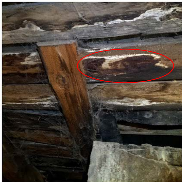
Fot. 19-22. Więźba dachowa – widok porażenia biologicznego desek połaciowych grzybem domowym ( Serpula lacrymans ) różne stadia rozwoju. Rozwój porażenia biologicznego w wyniku zawilgocenia – zagrzybienie powierzchni desek, rozkład strukturalny, utrata właściwości mechanicznych.
