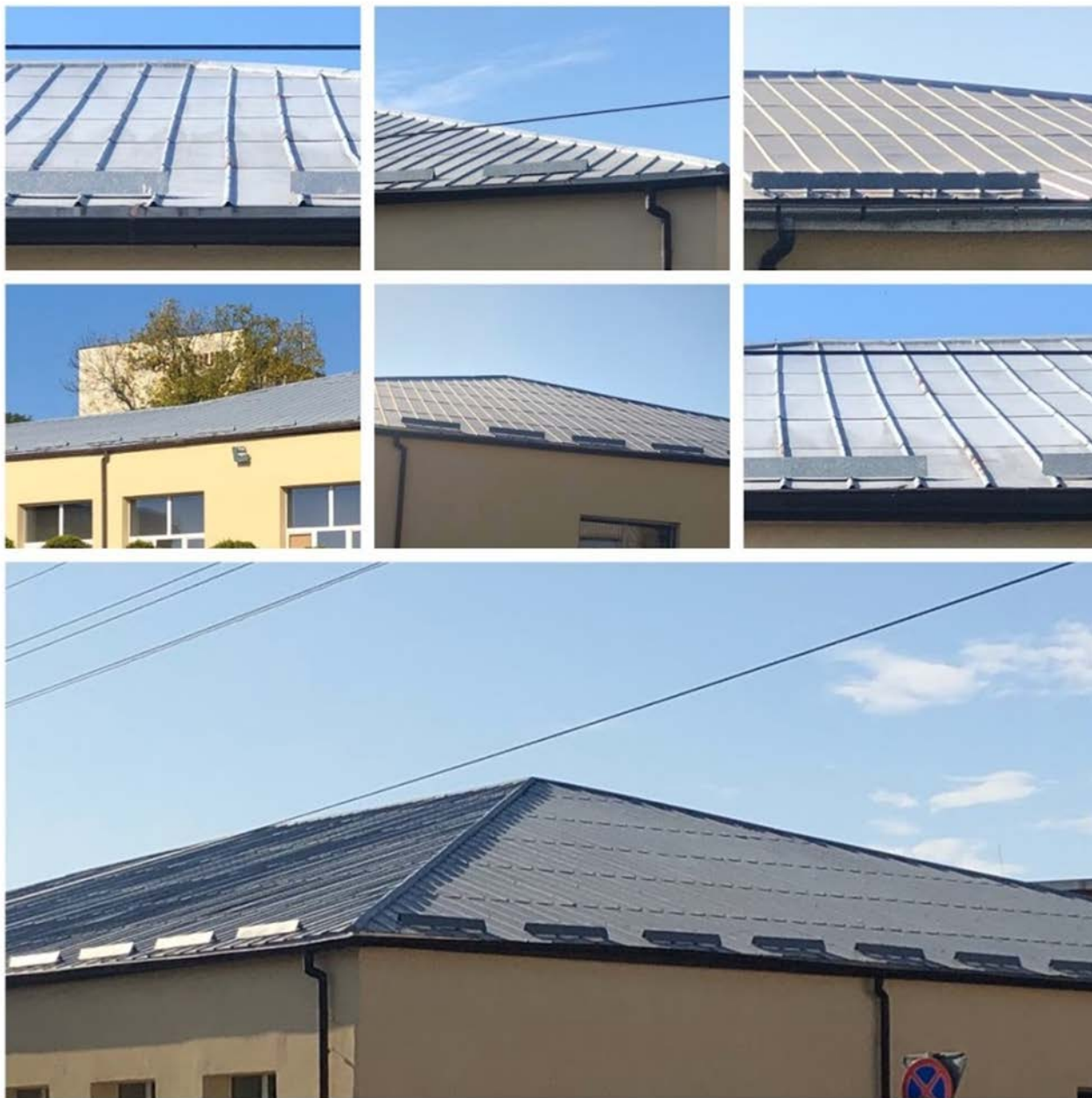
Fot. 3-9. Pokrycie dachu – blacha stalowa ocynkowana
