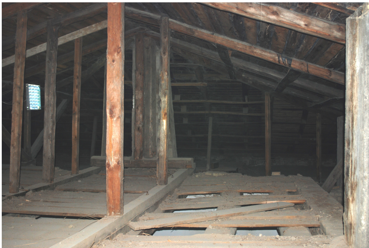
Fot. 5. Konstrukcja dachu (podparcie krokwi w kalenicy)
