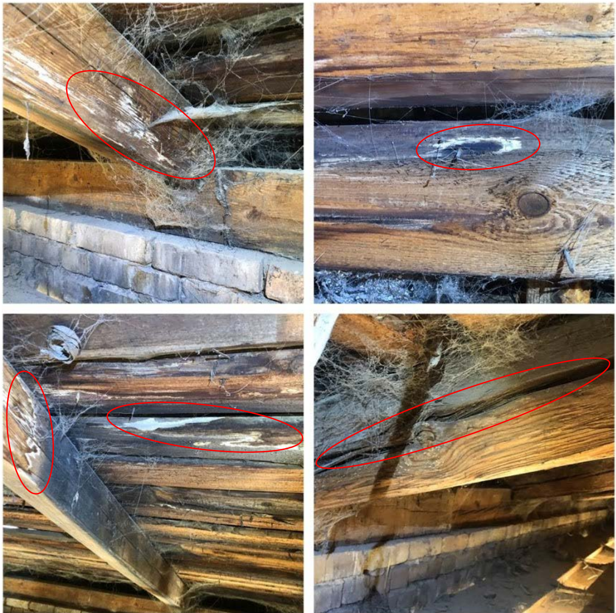
Fot. 27-30. Więźba dachowa – zagrzybienie desek połaciowych - grzyb domowy ( Serpula lacrymans ), spękania krokwi.
