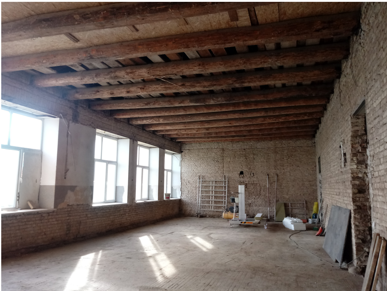
Fot. 3. Widok na belki stropowe (w całym budynku układ belek jest taki sam)
