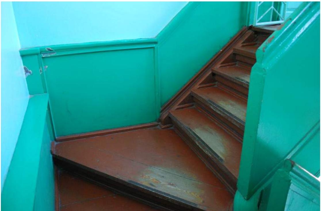
Zdj. nr 5. Klatka schodowa – spocznik pośredni między parterem a piętrem – widok w stronę piętra
