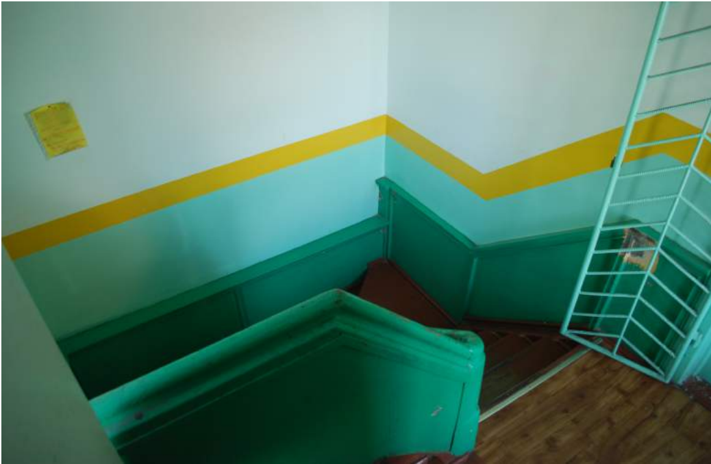
Zdj. nr 7. Klatka schodowa – spocznik pośredni między piętrzem a poddaszem – widok w stronę piętra
