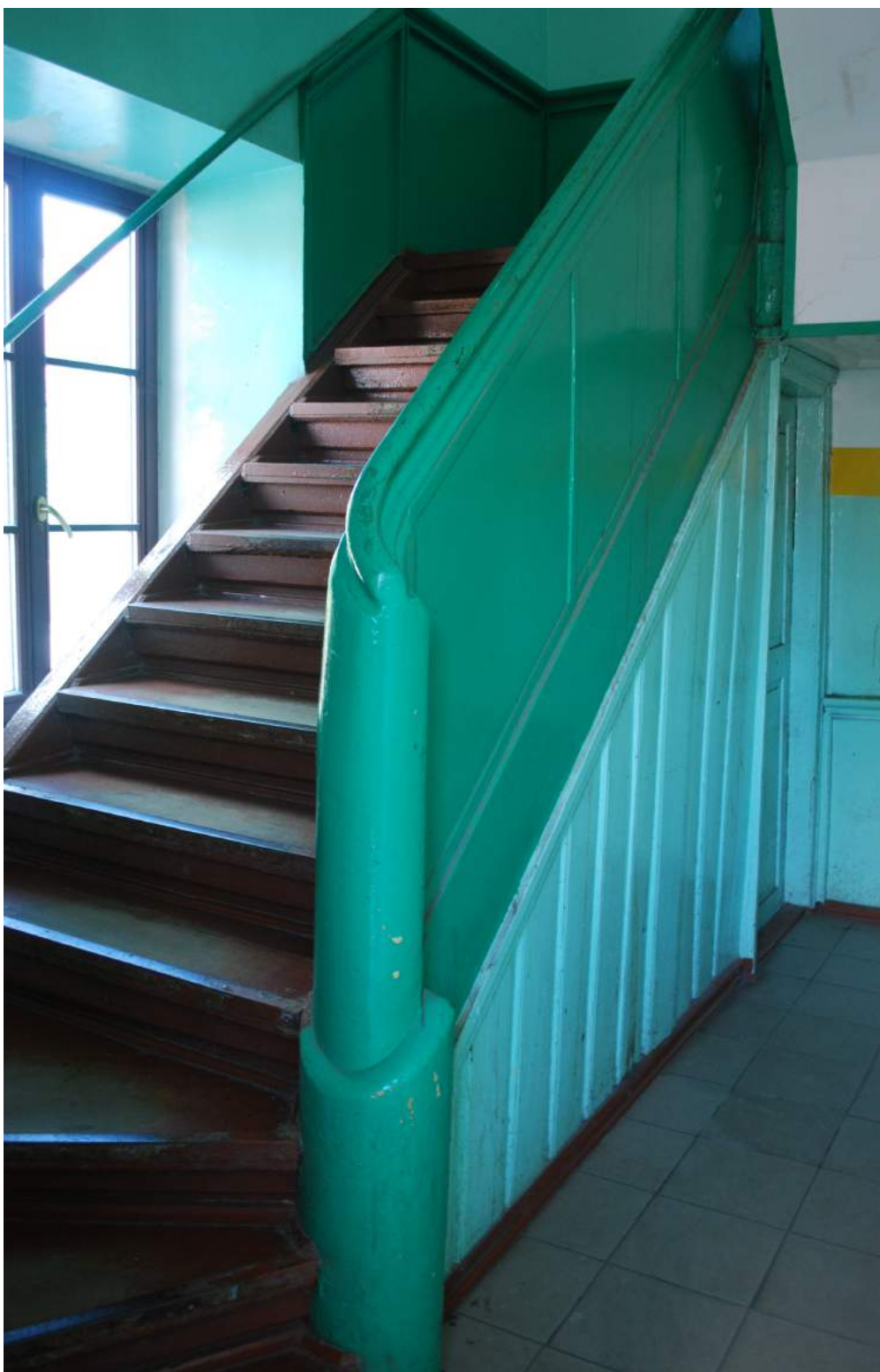
Zdj. nr 2. Klatka schodowa – parter – widok na balustradę
