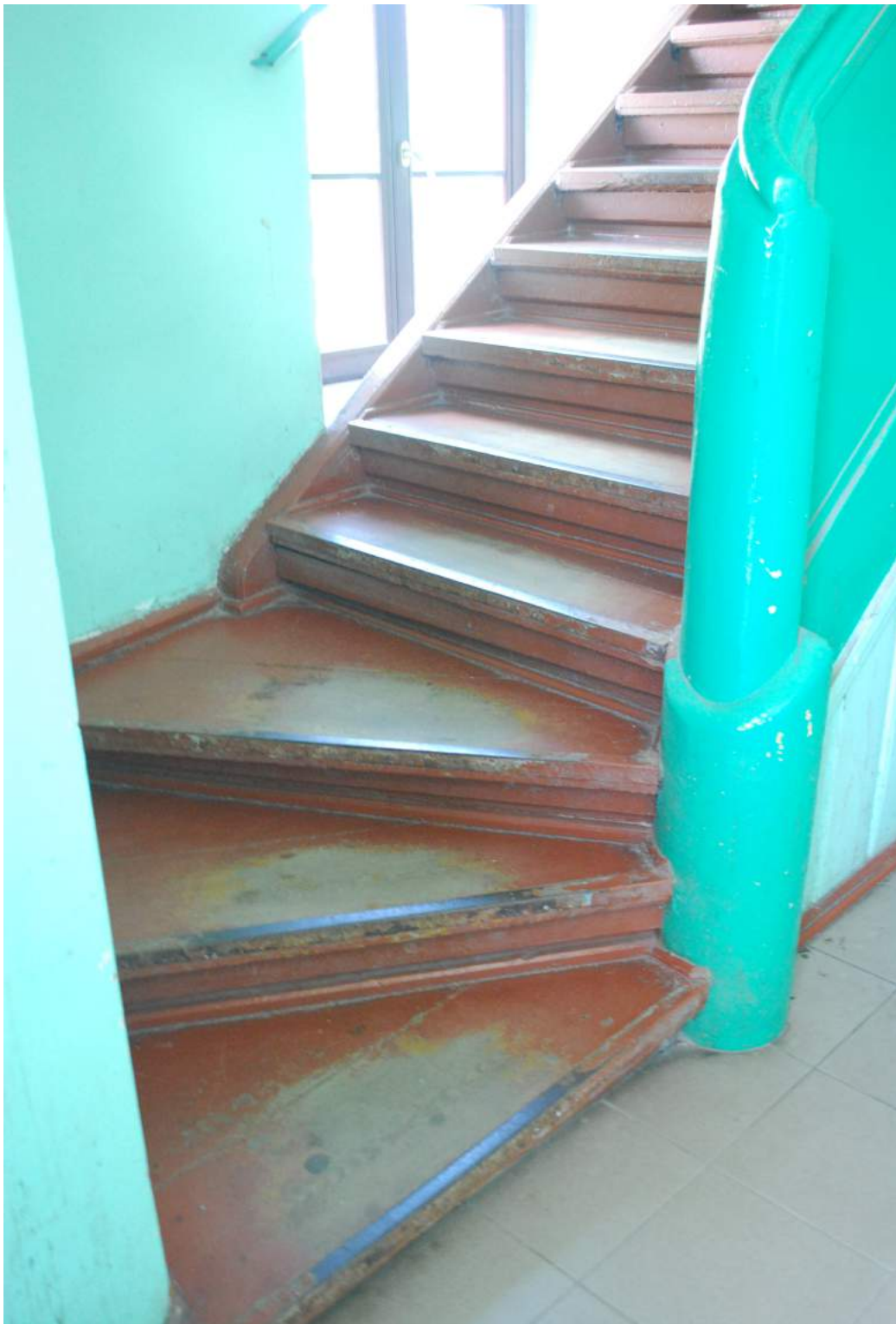
Zdj. nr 1. Klatka schodowa – parter – widok na bieg schodowy
