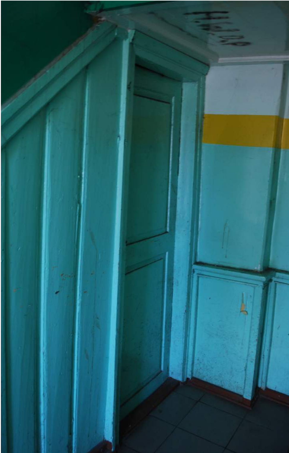
Zdj. nr 3. Klatka schodowa – parter – widok na drzwi do pomieszczenia pod biegiem schodowym
